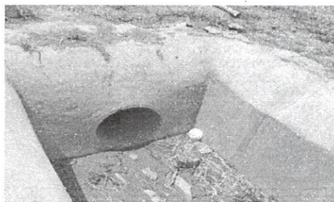
Fotos local: sistema de drenagem
