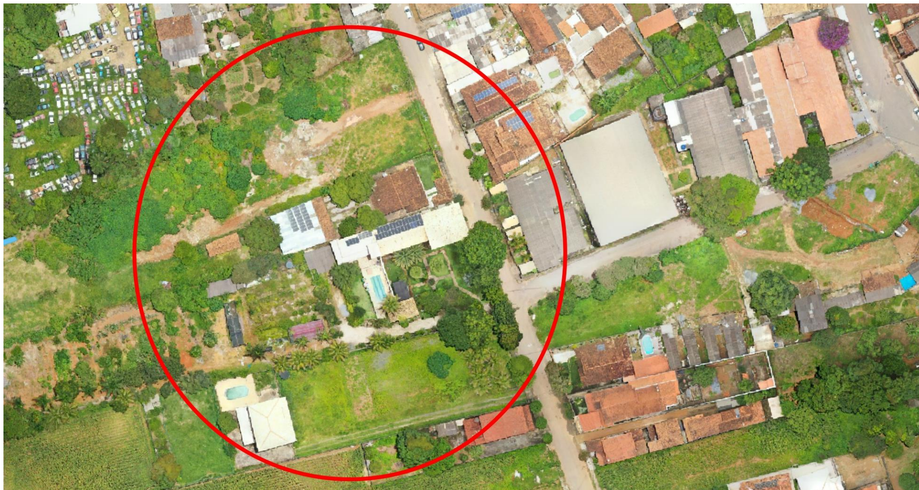
Rua Kalil Murad - Alagamento
