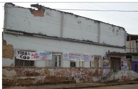
Figura 02: Vista do auditório antes da reforma.
